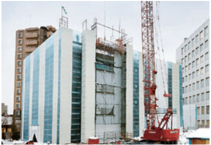
建設工事中新校舎2号館
